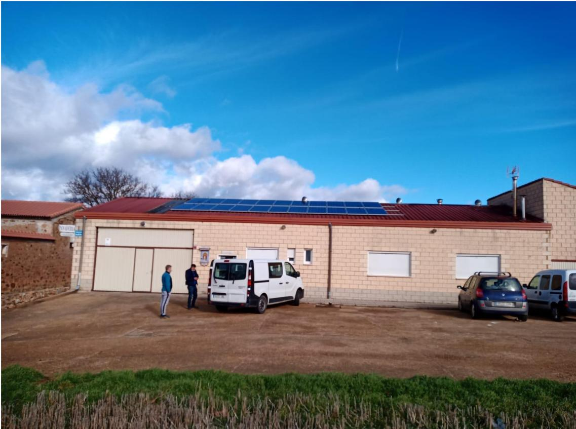
Instalación de equipos de producción energética, concretamente una instalación fotovoltaica que incluye 22 paneles de 330 W, consiguiendo una producción de 7,2 kwh
